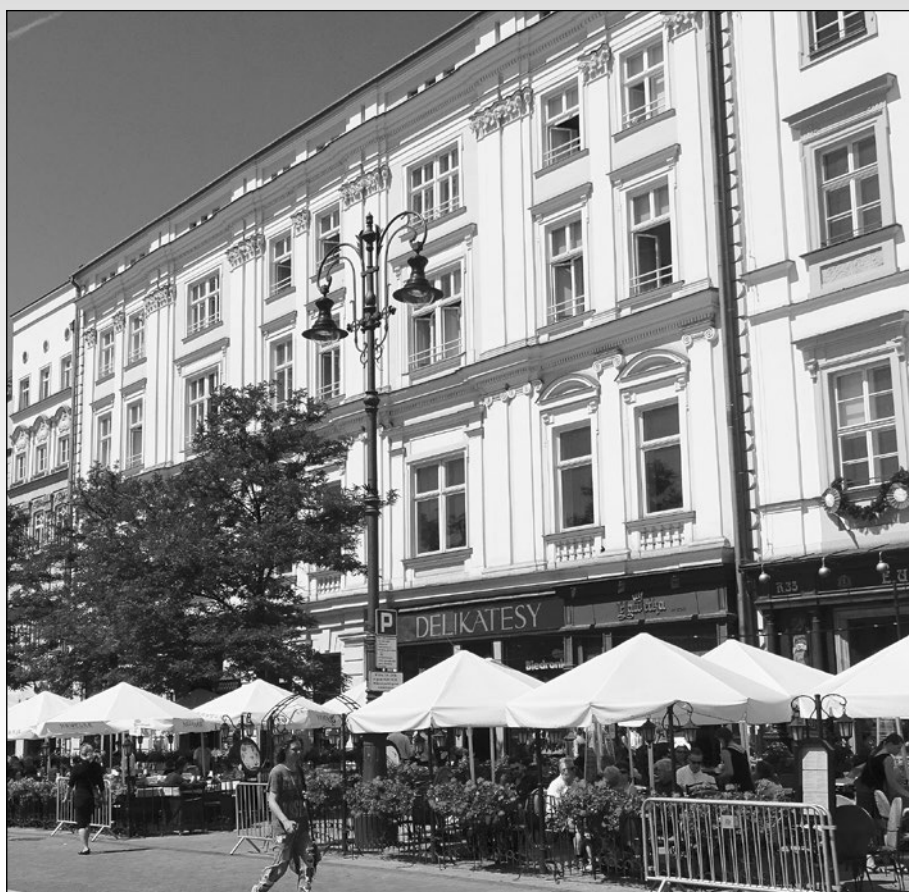
Pałac Spiski – obecny wygląd budynku, na terenie którego znajdowała się oficyna Schedlów
